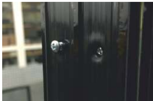
Schraube am Weg zum Einbauort öffnen und beim Verglasen auf der Baustelle verschließen.
